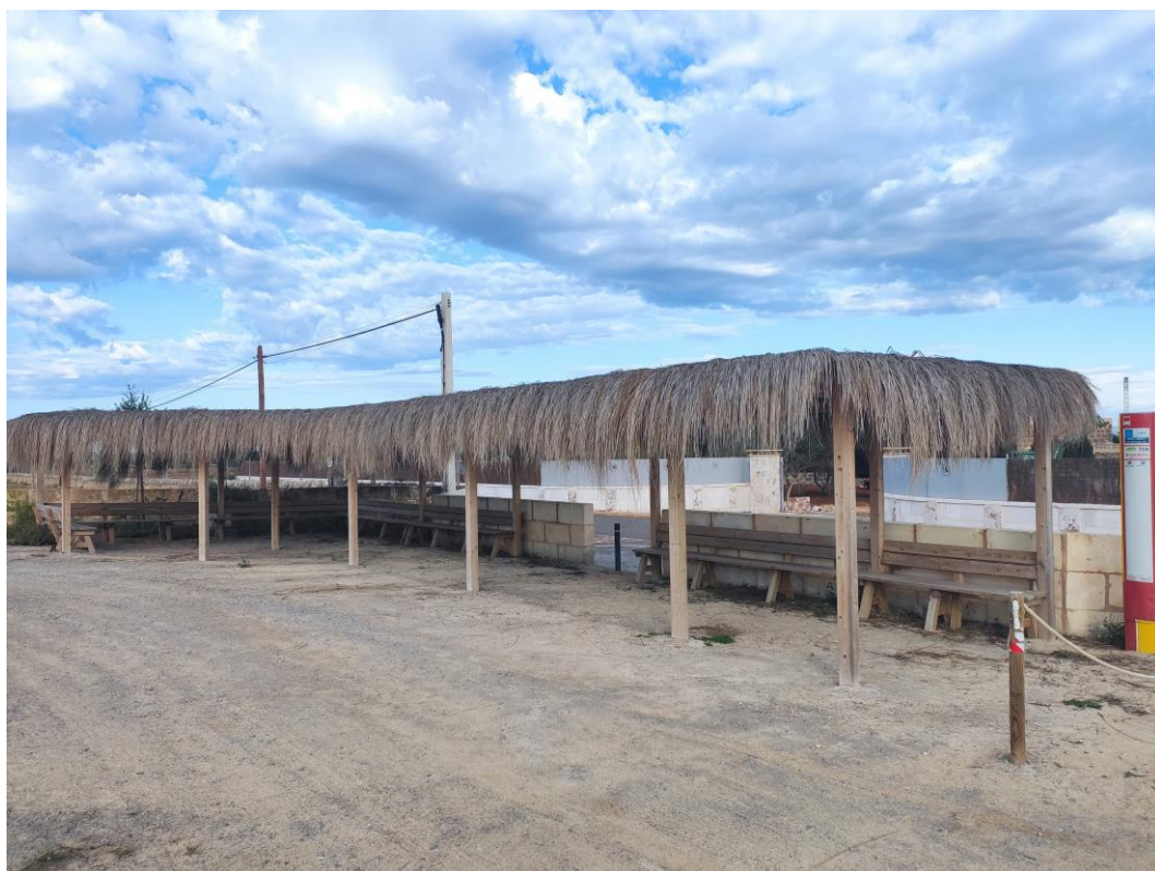
Fig. 22. Marquesina de transport públic a Sa Barralina Font: Elaboració pròpia
