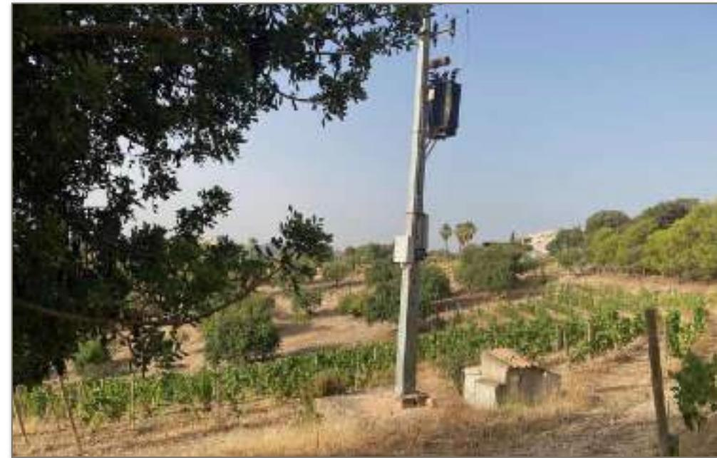
**Llegada de la línea de AT a la finca, transformador y contadores de BT**
