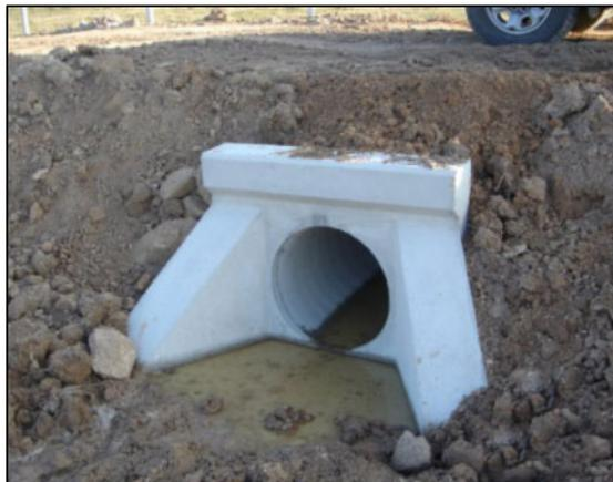
Ilustración 17 - Ejemplo obra de paso con embocadura prefabricada
