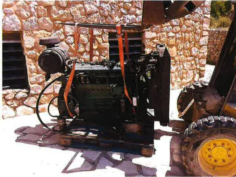
33. Sustitución de generador eléctrico en el PNMTA de Cabrera
