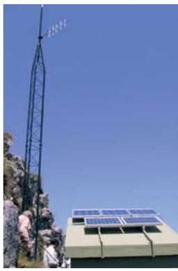
Instalación Fotovoltaica para alimentación de repetidor de radio-taxi
