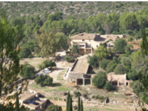
VISTA DE LES CASES I EDIFICIS AUXILIARS DE LA POSSESSIÓ
