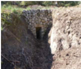
MINA D'AIGUA DES TRAMUNTANAL
