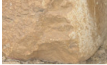
PETJADA DEL CAVALL DEL COMTE MAL A LA FAÇANA DE LA FINCA
