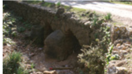
PONT DEL TORRENT DE GALATZÓ
