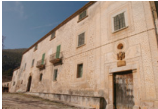
CONJUNT ARQUITECTÒNIC DE LES CASES
