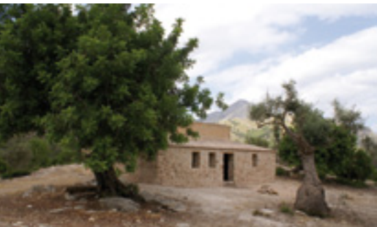
CONJUNT ARQUITECTÒNIC DES TRAMUNTANAL
