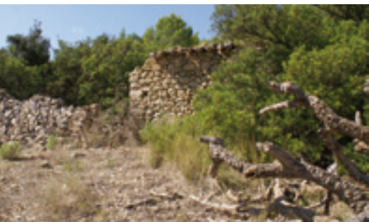
CASETA DE ROTER EN SA VINYA
