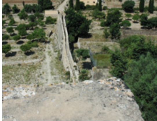
DETALLE DEL CONJUNTO HIDRÁULICO
