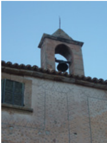
DETALLE DE LA ESPADAÑA
