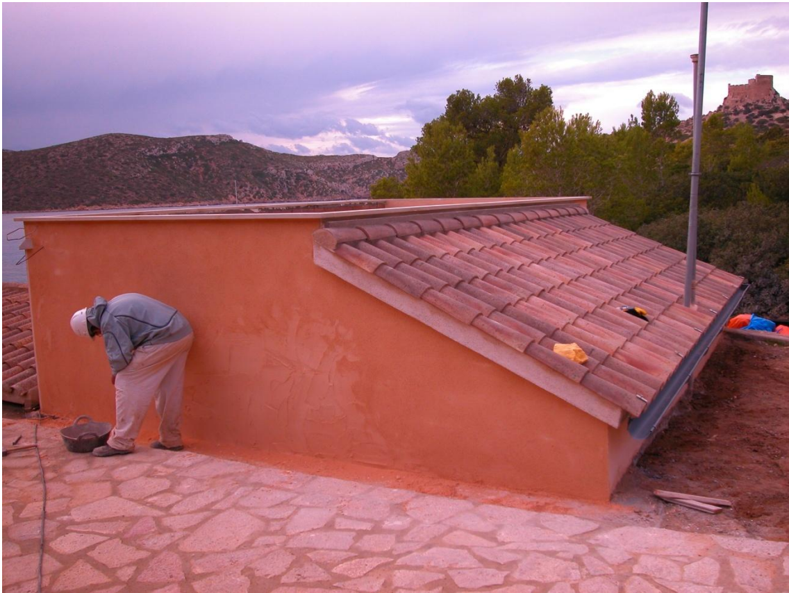
Depósito de almacenaje de gasoil
