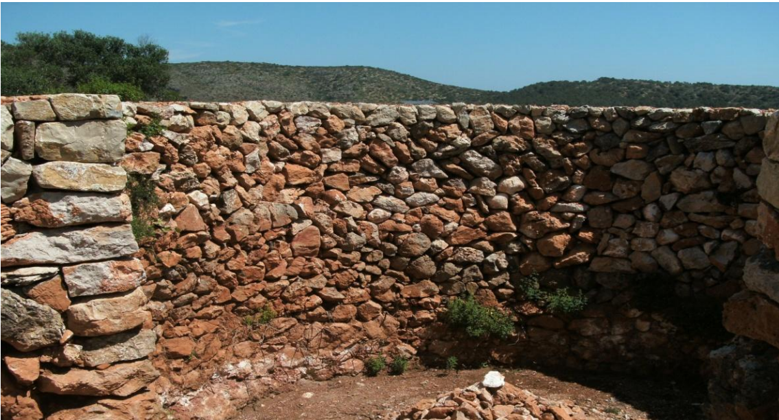
Restauració Forn de Calç (Es Caló d'es Forn)
